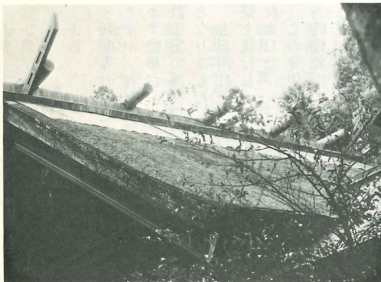
葺き替えが決定した御本殿御屋根
