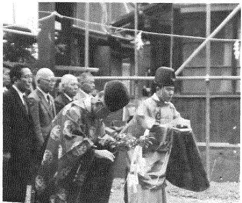
十二月二日 上棟祭を奉仕
