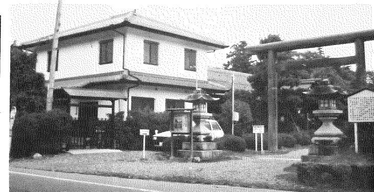
増築された新館の外観
